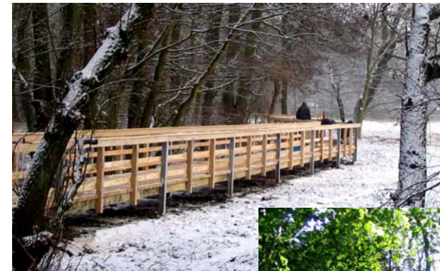
Steganlage nach der Fertigstellung
